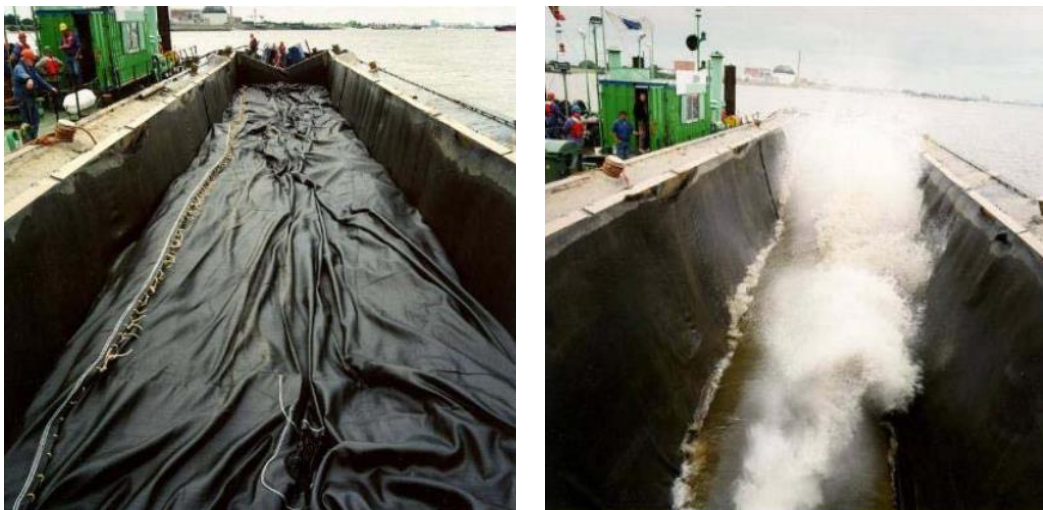
Figura 34. Lanzamiento desde el gánguil de los Geocontainers
